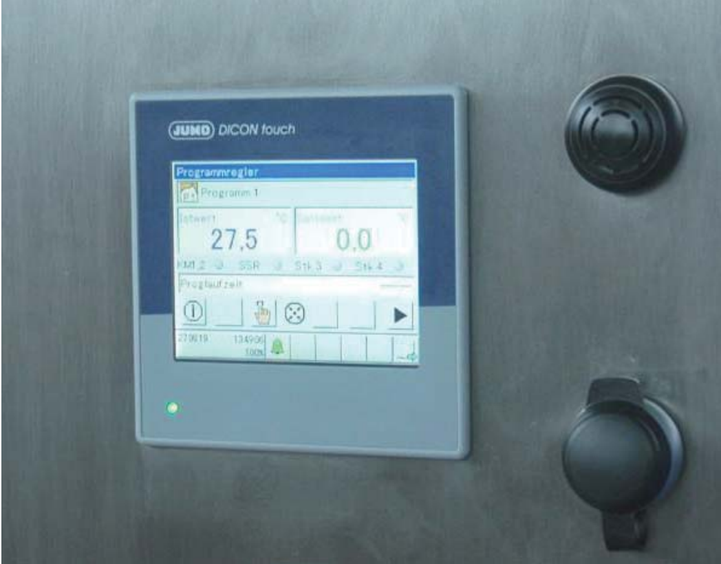
İnşaat paneli - operatör seviyesi
